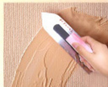
既存のビニールクロス
