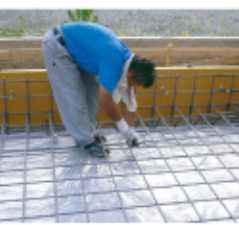
↑鉄筋を密に汲み上げて行きます。
