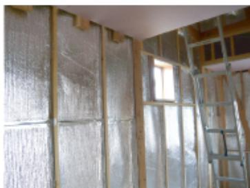
↑室内壁面遮熱シート施工
