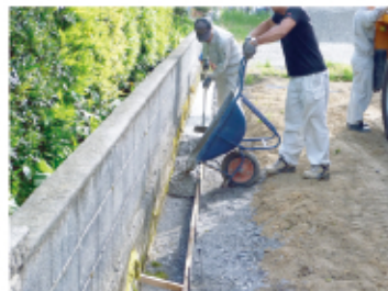
↑コンクリートを流し込み基礎が完成しました。
