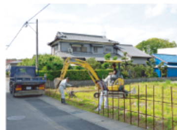
↑重機を敷地内へ搬入して作業開始です！
