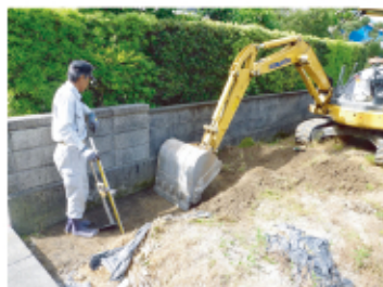
↑隣地との境界にブロック積み用の基礎を作りました
