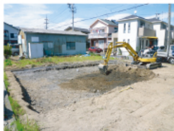
↑表面の畑土を除去して碎石を敷き込みました。
