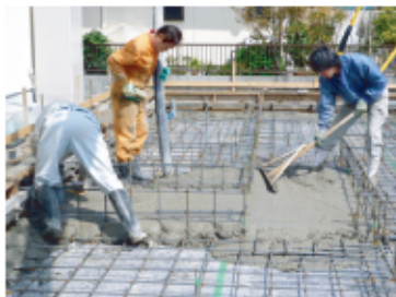
↑ コンクリート打設
