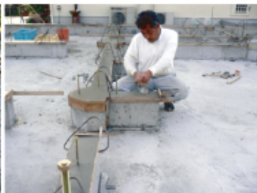
↑ 基礎天場均し作業です。
