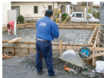
↑ 基礎配筋検査の様子です。
