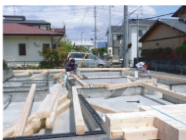
↑ 土台据付け作業中です。
