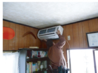
↑新しいエアコンの設置作業中です。
