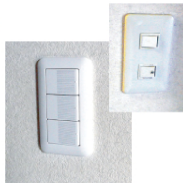
↑右上は交換前の「シーソー式スイッチ」。ワンタッチ式のスイッチは操作性も抜群です。
