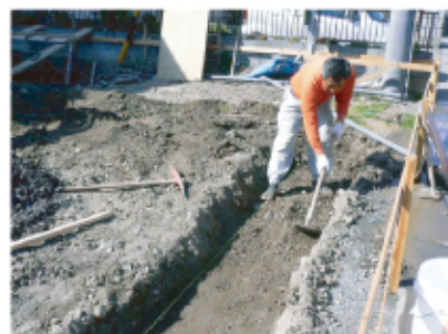
↑ 掘り方作業中です。
