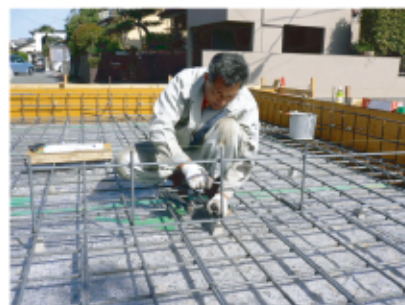
↑ 鉄筋を組上げていきます。
