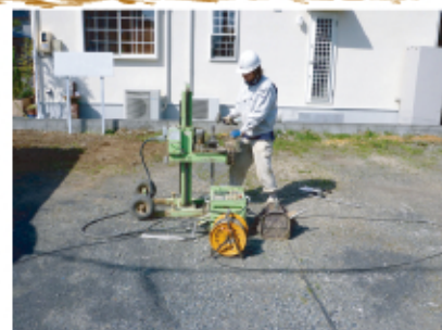
↑ 地盤調査の様子です。
