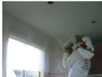
↑ 健康塗り壁ダイアトーマスを吹き付け工事中です
