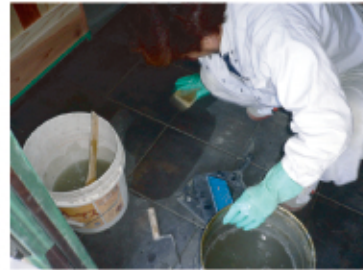
↑ 玄関部分にタイルを貼っています
