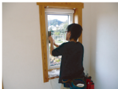
ガラスフィルム施工中の様子
