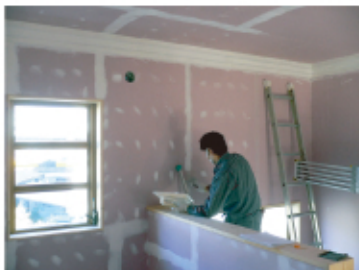
↑ 内装パテ施工中の様子
