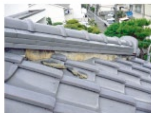
↑ 施工前の様子です。
