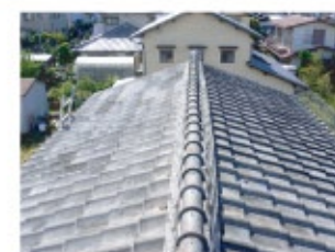
↑ 施工前の様子です。
