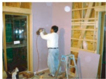
↑下地ボードを施工中です
