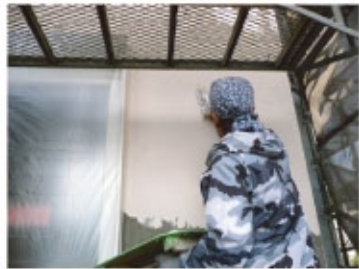
↑外壁の塗り壁を施工中です
