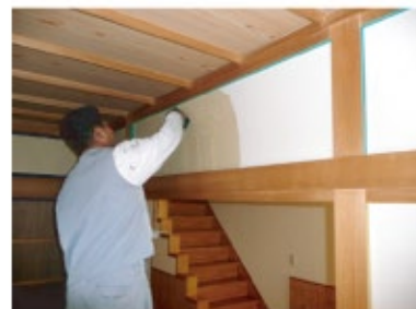
↑和室を施工中の様子です。
