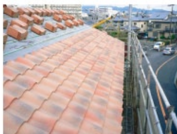
↑屋根瓦を施工しました。鮮やかな色が印象的です。
