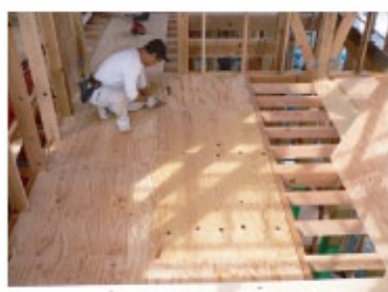
↑床下地にも構造用合板を施工し更に強度を増しています。
