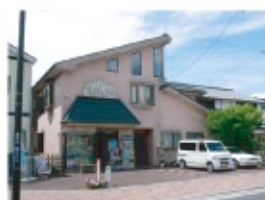
↑施工前の様子。
