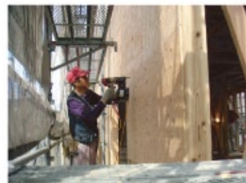
↑外装下地に構造用合板を貼り強度向上させています。
