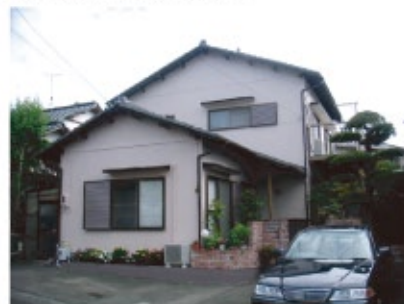
↑ 施工後です。明るく生まれ変わりました！
