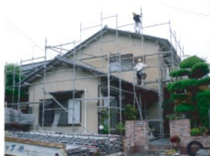
↑ 施工前の様子です。
