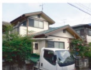
↑ 施工前の様子。
