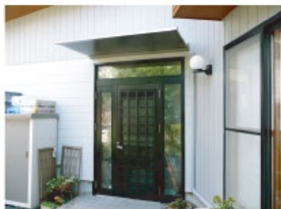
↑ 施工後です。玄関ドアを取替えして、おしゃれなポーチひさしが付きました！
