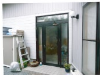
↑ 施工前の様子です。
