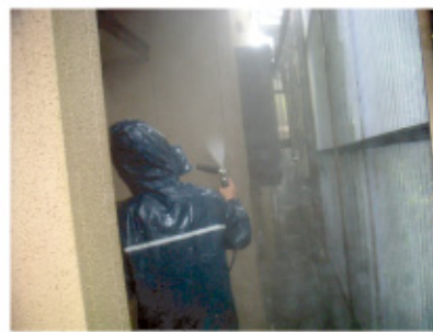
長年の汚れを洗い流して下地処理をしていきます。
