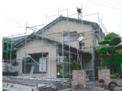
安全な作業の為に仮設足場を設置しました。
