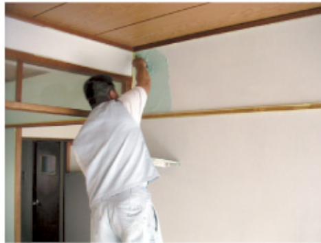
施工中の○様のコメント
