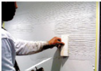
↑健康塗り壁ダイアトーマスを塗りつけ、乾かないうちに「クシ」で模様をつけます。存在感あるアクセント壁になります。
