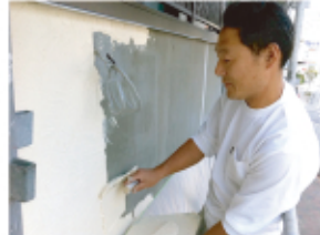
↑看板設置壁の下地は塗り壁仕上げです。
