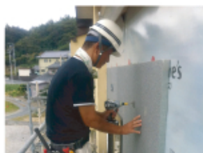
↑まずは外断熱材「ナンネンボード」を貼り付けます。
