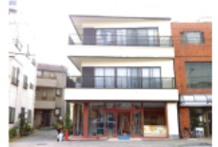
↑塗装工事が完了し美しく生まれ変わりました！
