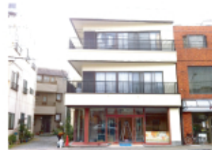
↑塗装工事が完了し美しく生まれ変わりました！
