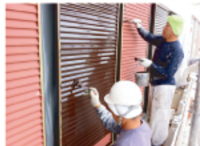
↑外部塗装の様子。丁寧に美しく仕上げていきます。
