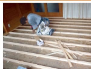
↑床貼りの下地を施工します。高さ調整は慎重に丁寧に行います。
