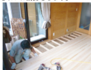
↑美しい無垢桧の床材です。一枚ずつ丁寧に施工していきます。
