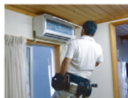
↑交換作業中の様子。丁寧な施工を心がけています。
