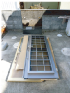
↑交換用のドア枠の組み立て中の様子です。
