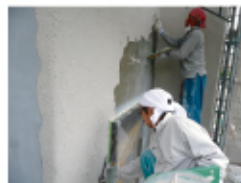
← 外壁の塗り壁の仕上げの様子！
