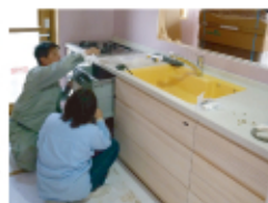
← システムキッチンも取り付け完了！
