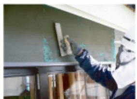
←外壁に柔軟性と強度を与えるモルタル施工の様子です。
