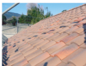
←屋根瓦が葺き終わりました。色むらが印象的な瓦です。
