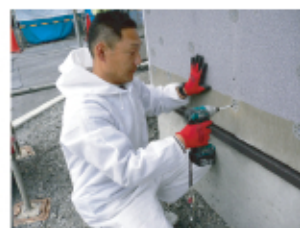
←外壁面に外断熱ボードを貼り付けていきます。
