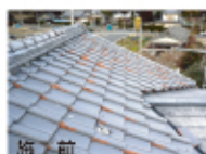
劣化した屋根瓦も新規に葺き替えが完了しました！
