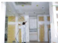
←天井にダイアトマスを吹付けました。
