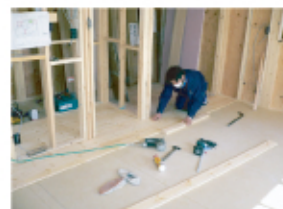
←室内では大工さんが天然木無垢フローリングを施工中です。
