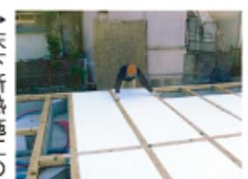
→床下断熱施工の様子です。真冬の冷気もシャットアウトします！
