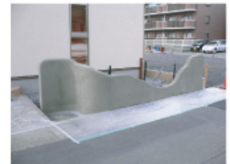
↑曲線を生かしたデザインのエバブロック施工中！
