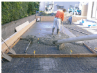
↑駐車スペースにコンクリートを流し込んでいきます。
