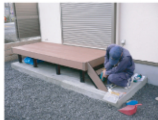
↑アルミ製ウッドデッキの組み立て中です。
