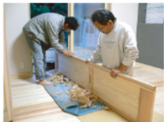
↑室内建具は一本ずつ調整をしながら取付けていきます。
