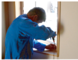
↑サッシの動作確認と調整を行いました。
