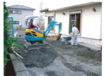
↑屋外では外構工事がスタートしました。
