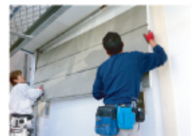
↑EPS外壁の取付け作業の様子。
