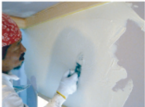
↑健康塗り壁ダイアトマスの仕上げ作業中です。
