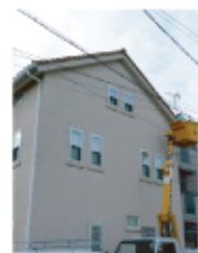
←高所作業車を利用して安全作業を行いました。
