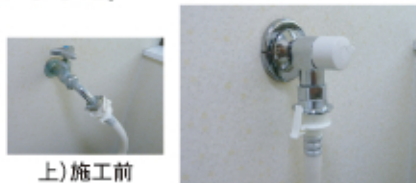
上)施工前 右)施工後
