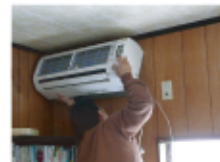
施工中の様子
