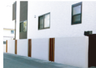
↑外構も完成しました。建物と 同様シンプルモダンです。
